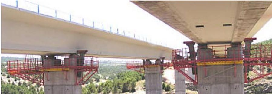
Jede Brücke des Umgehungsringes um Teruel besteht aus zwei Viadukten. Der Vorschub der acht Deckbrücken erfolgt mit dem wirtschaftlichen und flexiblen integrierten Hydrauliksystem von Enerpac. Das auf den Druckfundamenten installierte Vorschubsystem von Enerpac wird für den Aufwärts-Vorschub genutzt.
