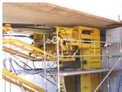
Das flexible Brücken-Vorschubsystem mit den vier Hydraulikhebern mit Hohlkolben hinter dem Stützblock auf dem Druckfundament
