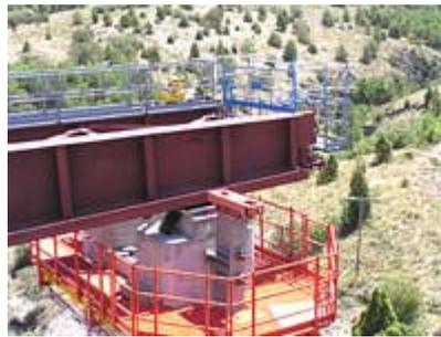
Diese Abbildung zeigt deutlich den Vorschubsteg auf einem der Pfeiler der ersten Brücke und die Seitenführung
