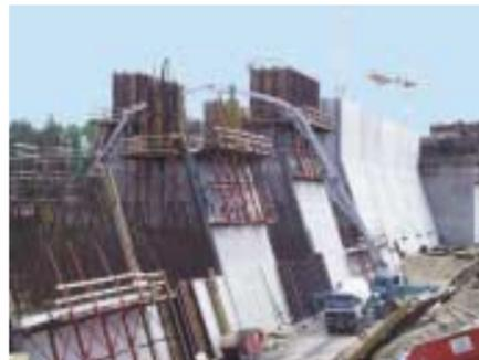
Betonieren der Kammerwände
