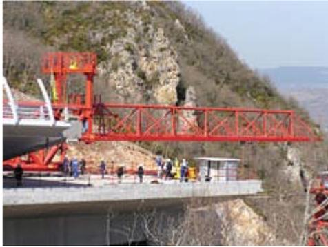
angehoben und dann horizontal verschoben wird. Aufgrund des verstellbaren Vorbauschnebel am Ende des Brückenüberbaus kann der Brückenüberbau beim Anfahren auf den einzelnen Pfeilern abgesetzt werden.
