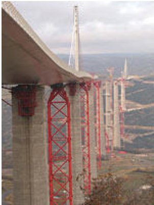
An allen Betonpfeilern und temporären Stützpfeilern aus Stahl werden hydraulische Vorschubsysteme von Enerpac installiert, welche die Fahrbahn des Millau-Viadukts weiter bewegen.
