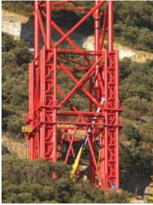
Nahaufnahme des temporären Stützpfilers T6 des Millau-Viadukts mit den beiden Teilen des Teleskopsystems.
