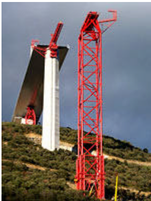
Die temporären Stütztürme T7 und T6 mit dazwischen dem Betonpfeiler P7. Im unteren Bereich des Turms T7 ist die Kubusstruktur mit dem hydraulischen Pfeiler-Hebesystem zu erkennen. Mit Hilfe des Krans werden neue Pfeilersegmente eingefügt. Das Rückholssystem für die Millau-Brückenspitze im vorderen Bereich nähert sich dem temporären Turm und kompensiert im Verlauf des Brückenvorschubs eventuelle Höhenabweichungen.
