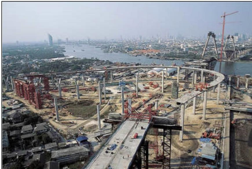
Das IRR- (Industrial Ring Road) Projekt in Bangkoks Haupt-Industriegebiet mit zwei Straßenabschnitten von insgesamt 13 km Länge, die durch zwei 172 m hohe Brücken miteinander verbunden sind.
