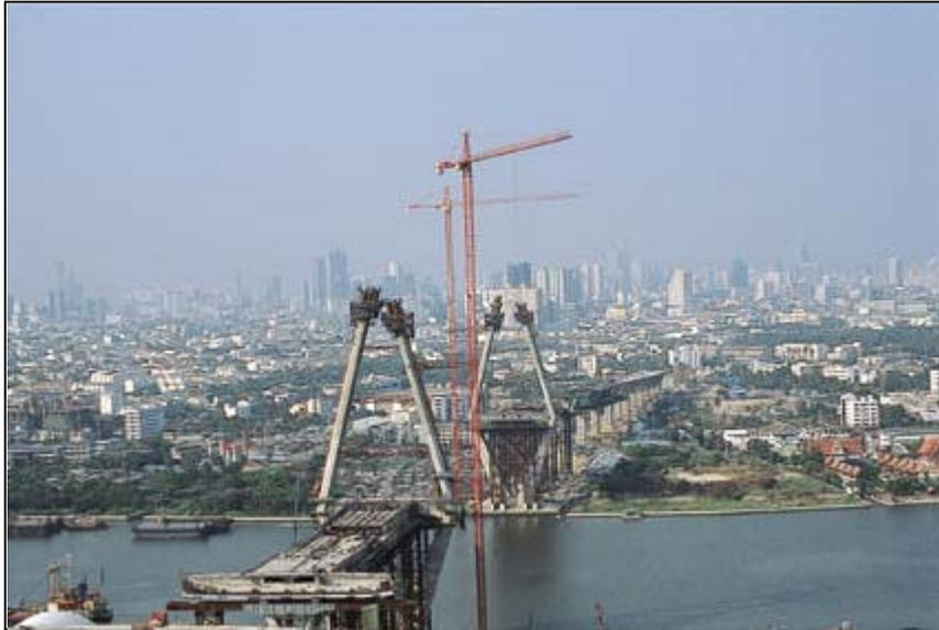
Um Schiffen den ungehinderten Zugang zum Hafen von Bangkok zu ermöglichen, muss die Fahrbahn des Verbindungsstücks zwischen den beiden Seilhängebrücken über dem Chao Phraya Fluss 50 m hoch sein.
