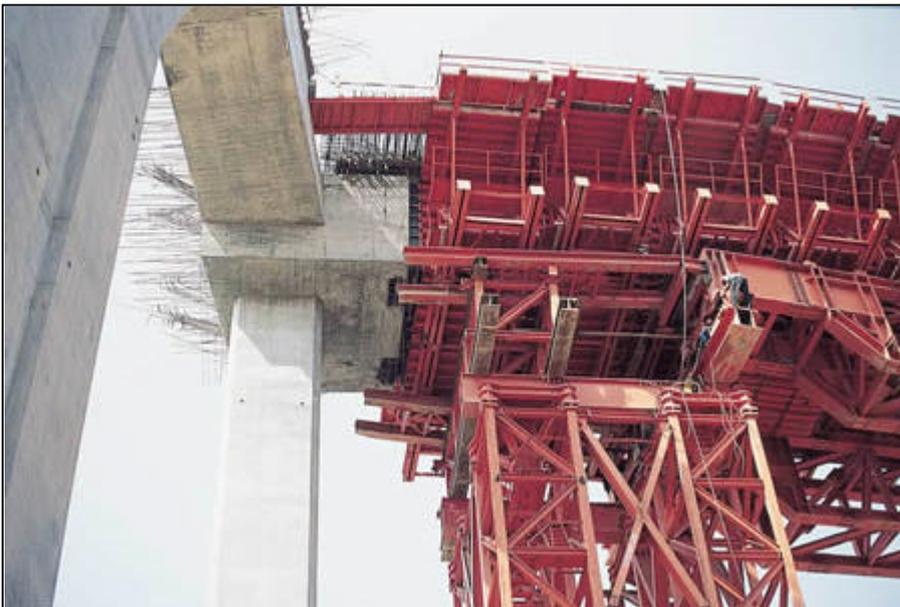
Um derartig riesige Stahlteile sicher und effizient in große Höhen heben, exakt steuern und positionieren zu können (es handelt sich mit 1200 t um möglicherweise den schwersten Verschalungsschlitten von ganz Südostasien), musste Hochleistungs-Hydraulik eingesetzt werden.
