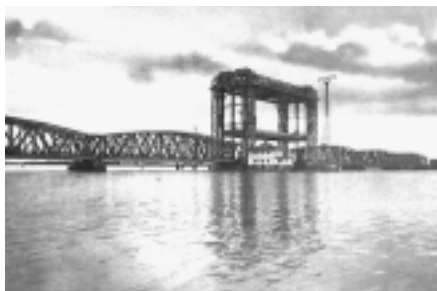
Gesamtansicht der Brücke vor ihrer Zerstörung, Foto: Sammlung Gisela May
